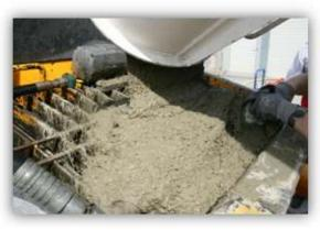
*B STRATOS RS* è una fibra in polipropilene, altamente tecnica, per calcestruzzo da spruzzo umido o asciutto. Il calcestruzzo da spruzzo rinforzato con B Stratos RS può essere usato per la messa in sicurezza di cave edili, di pendii, rocce e in generale nei tunnel.
